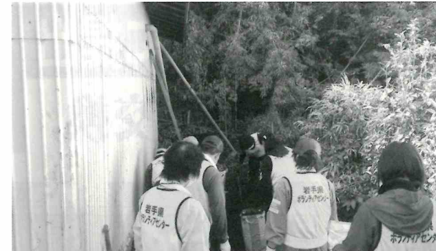
10月14日・岩泉町小本地区、家の外構の泥だし
