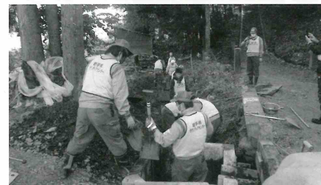
10月21日・岩泉町小本地区、側溝の泥だし
