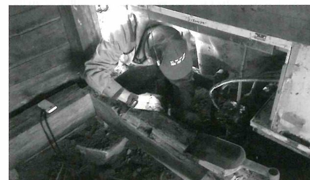
10月28日・岩泉町小本地区、床下の泥だし
